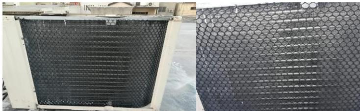
Figura 4. Serpentín de Condensadora antes y después de mantenimiento.
