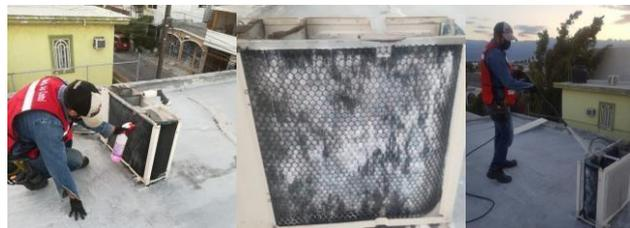
Figura 1. Proceso de Limpieza en condensadora
