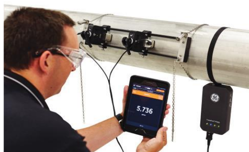
Figura 2.3 Utilización del medidor de flujo ultrasónico.
